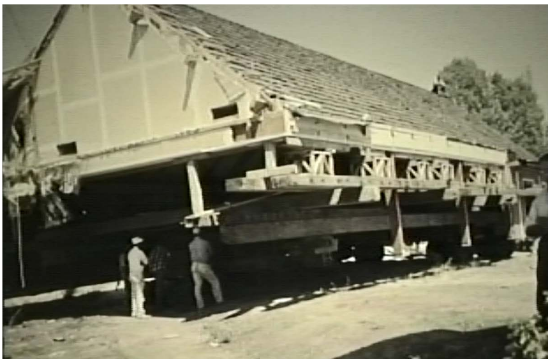
Строительство молитвенного дома на Franklin Blvd.
